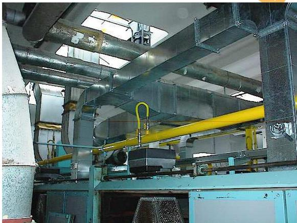
Отверстия для отсоса расположены вне рабочей области товара, в изоляционных пластинах над разделителем воздухопровода для сопловых камер. Воздух из сушильной камеры отсасывается из каждой секции сушильной камеры.
